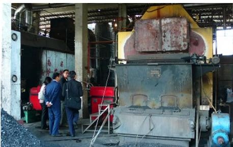
安装在现场的链条锅炉拨火助燃系统
