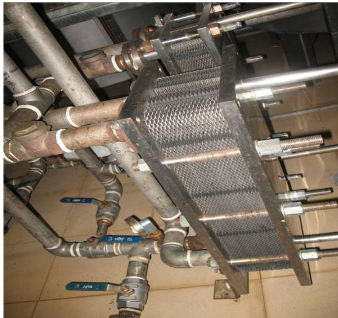
图 3-6 板框式换热器
