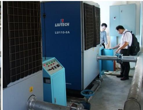
壓縮機熱水系統的控制版面
