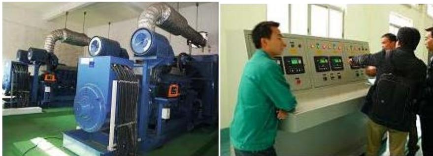
廠內的柴油發電機組      «電控系統»的外觀及面板操作裝置
