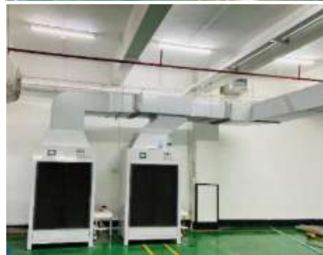
蒸發式冷凝器及預冷蒸發器雙效聯動系統
