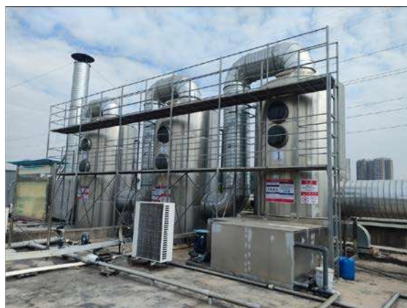
化學洗滌有機廢氣淨化系統
