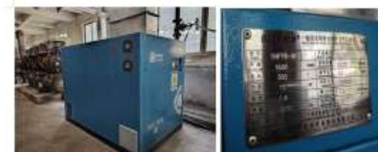
4台110kW及1台75kW空壓機
