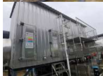
化學洗滌有機廢氣淨化系統
