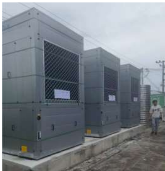
鑽機冷卻系統
