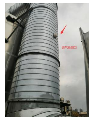
化學洗滌有機廢氣淨化系統
