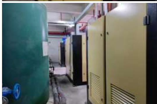
5 台 160kW 兩級壓縮螺桿空氣壓縮機
