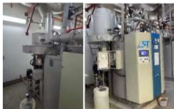
燃燒器改造 (左改造前, 右改造後)
