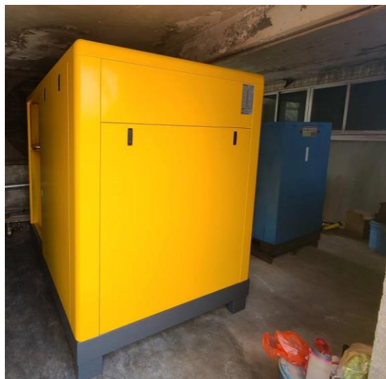
兩級壓縮螺桿空氣壓縮機
