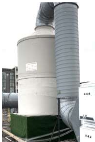
化學洗滌有機廢氣淨化系統
