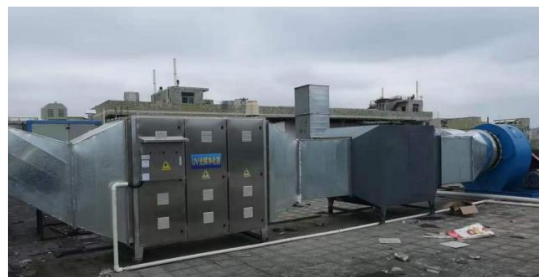
處理吹膜車間廢氣的 2#《UV 光催化及活性炭吸附淨化系統》外觀圖
