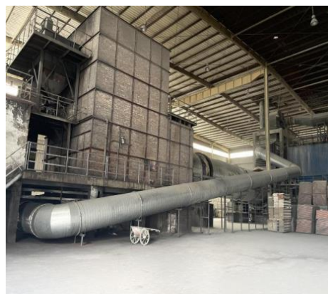
新增餘熱回收風管
