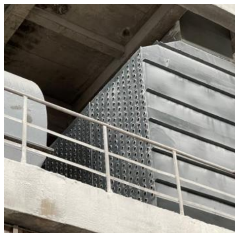
列管式熱風回收交換設備
