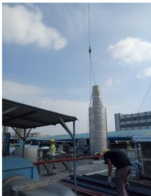
化學洗滌及紫外線光催化氧化分解裝置
