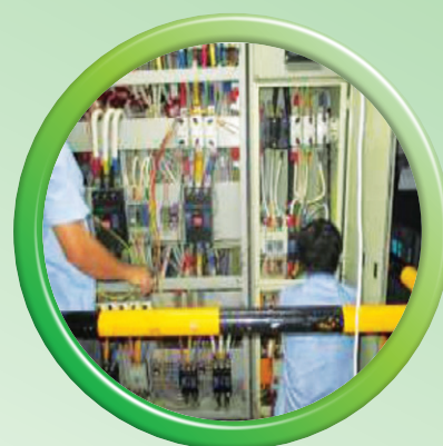
現場安裝電錶
