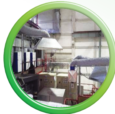
具備脈衝射流過濾器的抽氣系統
