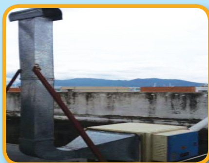
現場安裝的排放管道
