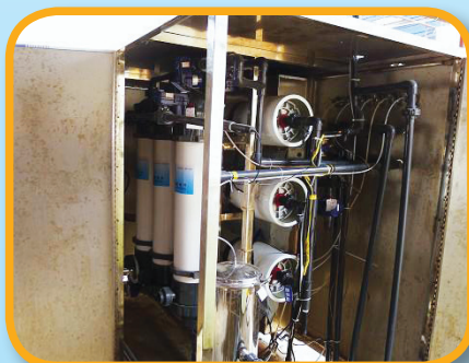
UF膜及RO膜過濾系統
