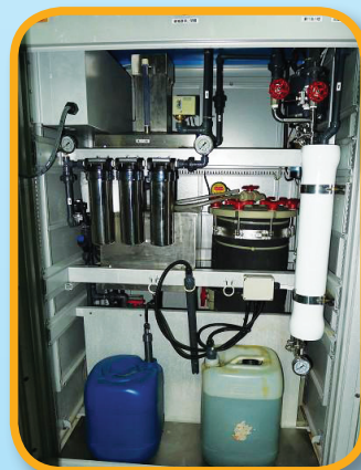
水斗液循環過濾系統內的配置
