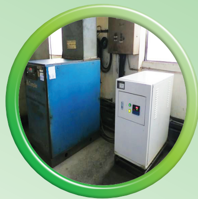
壓縮機廢熱回用系統（右）
