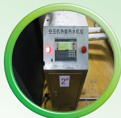
熱能回收系統的控制板
