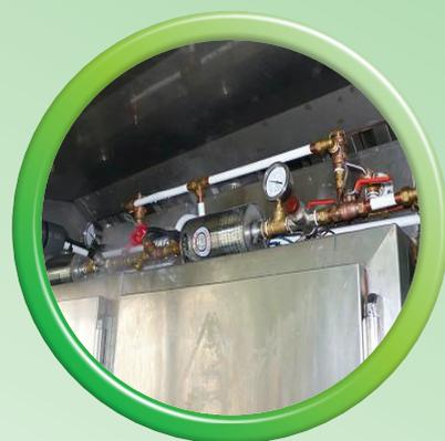
節能蒸櫃的熱交換回收器
