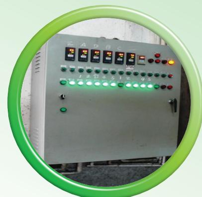
熱管式餘熱熱水器的控制系統
