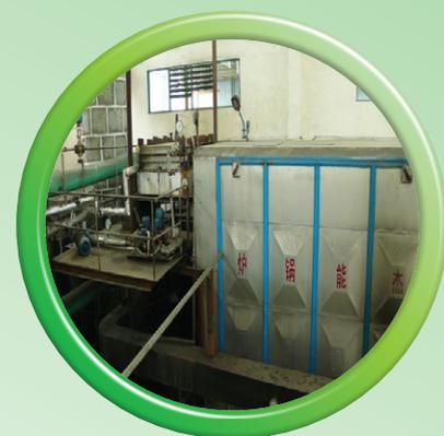
熱管式餘熱熱水器的外觀圖
