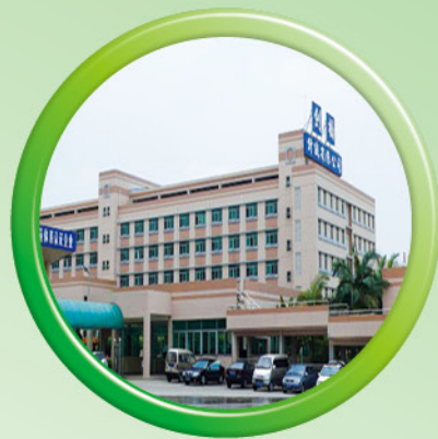
劍橋廠房外貌
