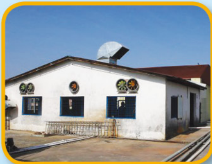
位於天台的空氣壓縮機房
