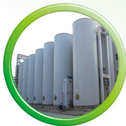
發酵罐的保溫外層及熱水箱
