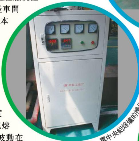
電中央鋁熔爐的操作開關
