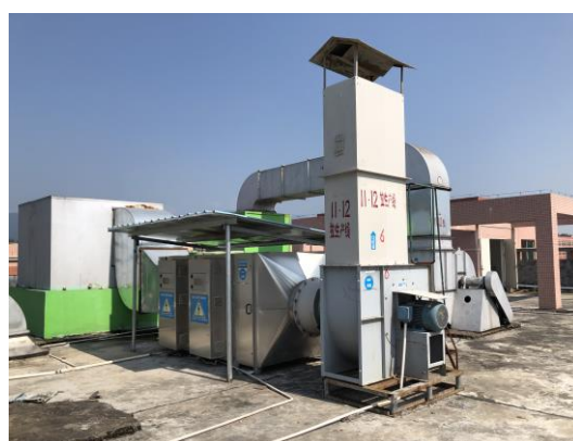
水噴淋、紫外線光解及活性碳有機廢氣淨化系統整體外觀
