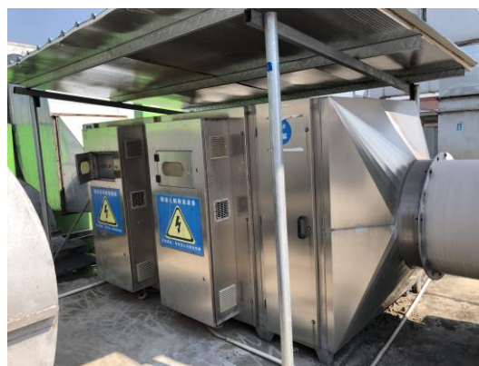
水噴淋、紫外線光解及活性碳有機廢氣淨化系統
