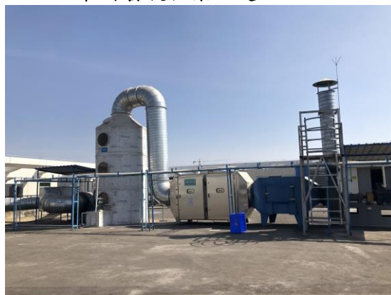
水噴淋、UV 光催化氧化淨化系統
