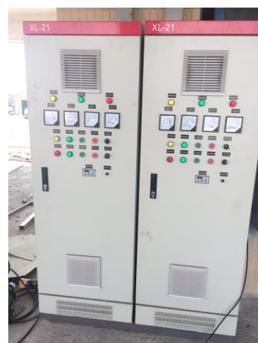
紫外線光解淨化系統的電控櫃
