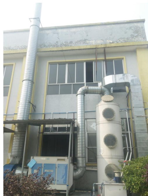
水噴淋及紫外線光解淨化系統
