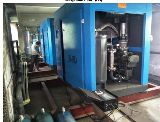
2台 55kW 永磁電機及變頻功能的節能螺桿空氣壓縮機
