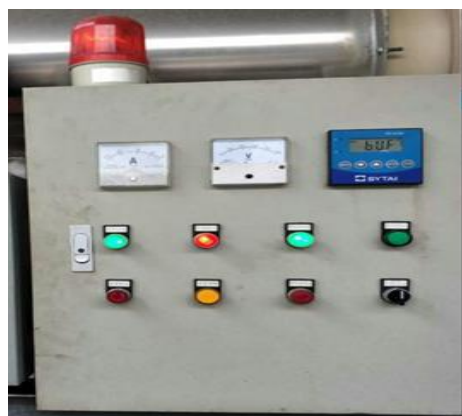
紫外線光催化氧化及活性炭吸附技術的組合式廢氣處理系統的操作開關
