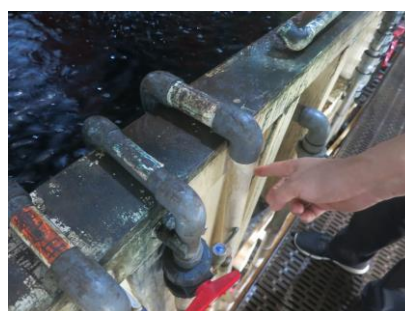
鉻化槽在線回用
