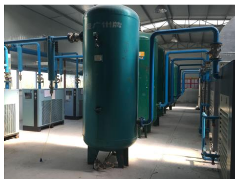
中央控制壓縮空氣系統
