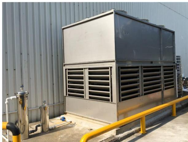
閉環式風冷式冷卻系統
