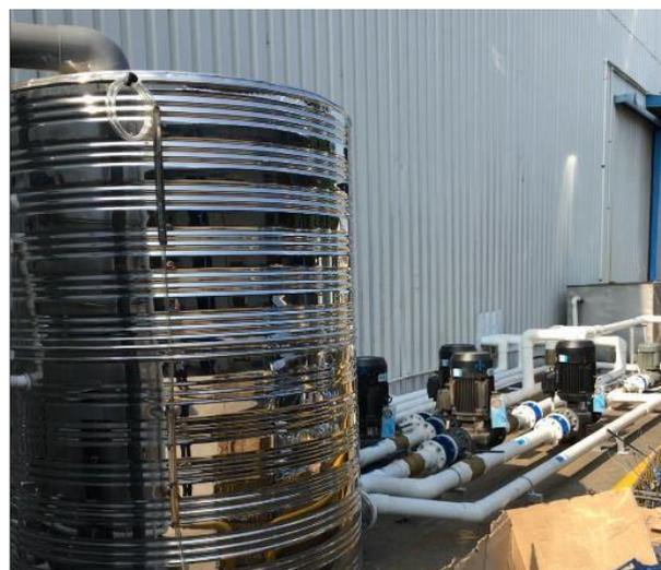
閉環式風冷式冷卻系統
