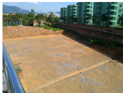
人工濕地工程現場
