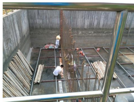
人工濕地工程現場
