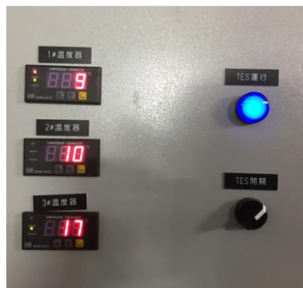
儲冷系統運行開關及溫度指示
