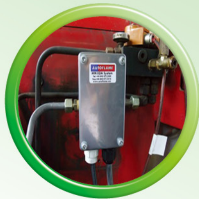
控制燃油進入鍋爐的伺服系統
