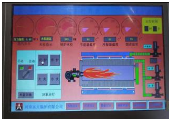
燃气锅炉操作接口
