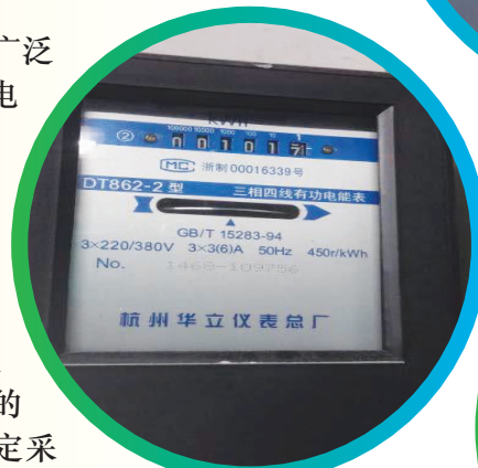
现场实测用电情况
