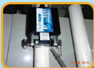
电磁波水垢清除系统安装位置
