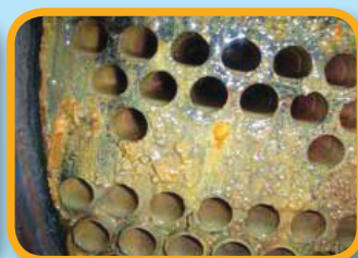
处理前散热器铁锈状况
