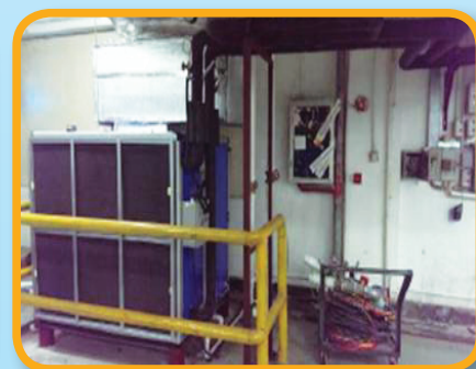
末端风柜安装
