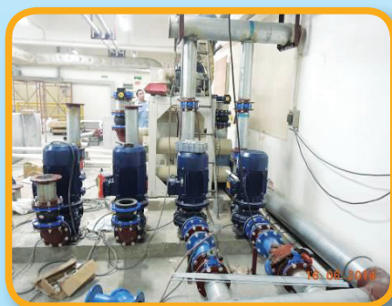
配套水泵及管道安装
