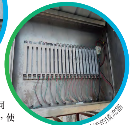
勤达厂房；废气引到天台的UV处理系统
