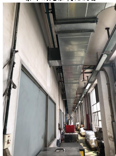
注塑车间有机废气收集
