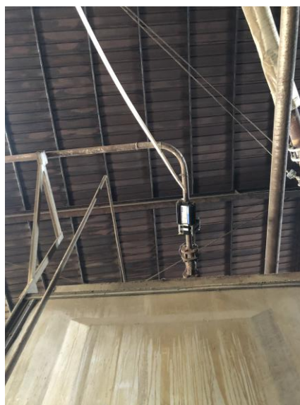
电磁波水垢清除装置 安装于蒸汽锅炉的管道上
