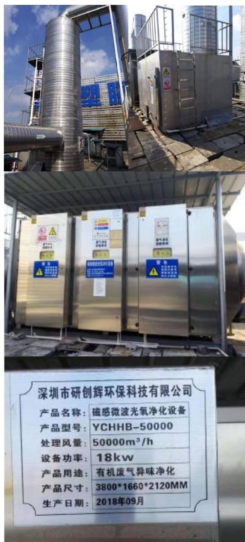
高效漆雾离心分离+干式过滤 UV 光催化氧化净化系统
