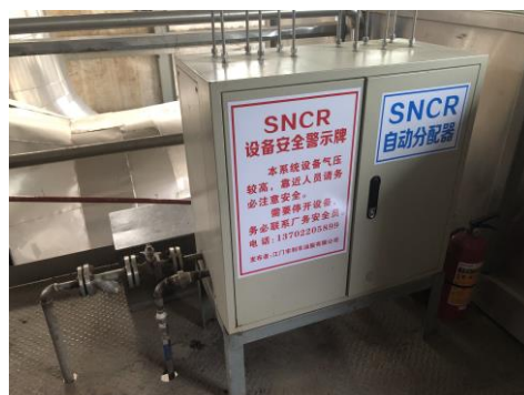
选择性非催化还原脱硝技术的加药装置
