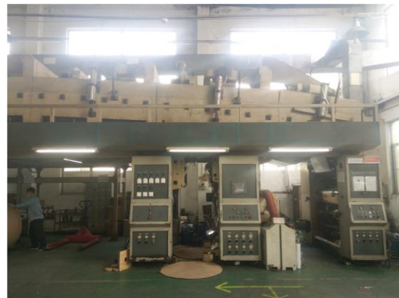
车间废气收集及处理设施
