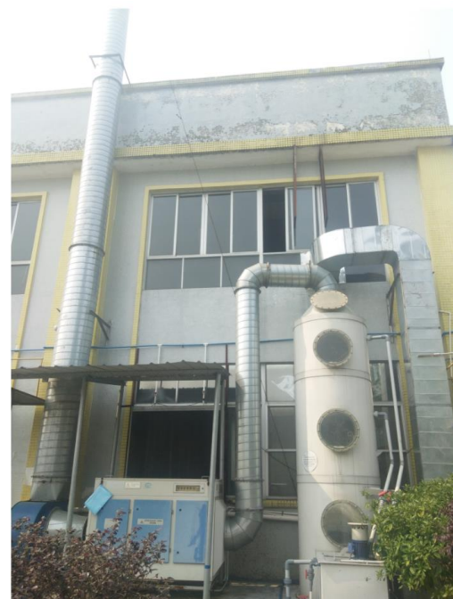
水喷淋及紫外线光解净化系统
