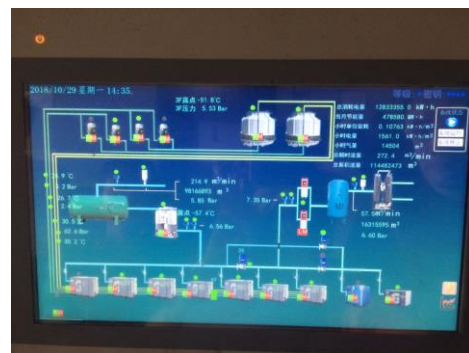
中央控制系统的操作介面
